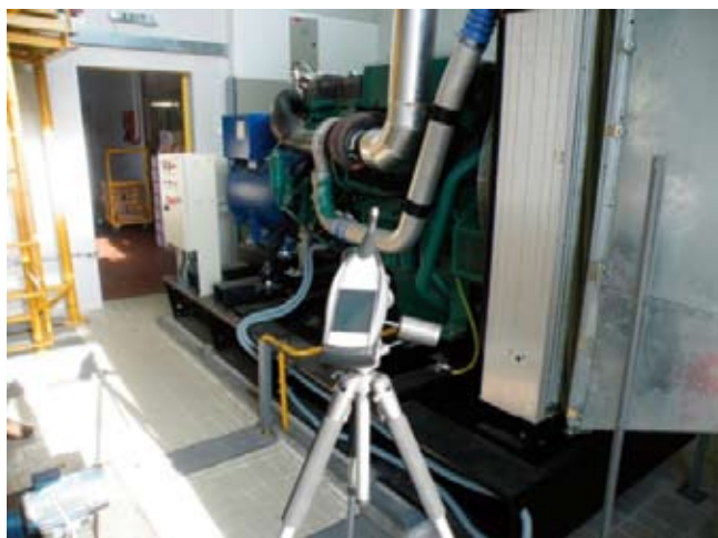
Слика 4.94. Примена опреме за испитивање параметара буке и њеног утицаја на радну средину - ADVANCED SOUND LEVEL METER ANALYZER 2250
