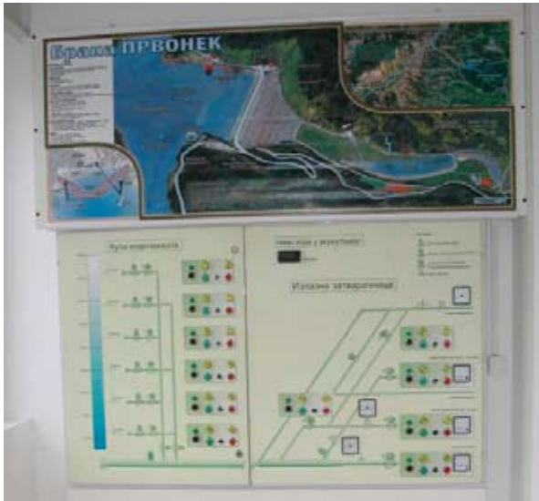
Систем даљинског управљања на брани Првонек, Врање
